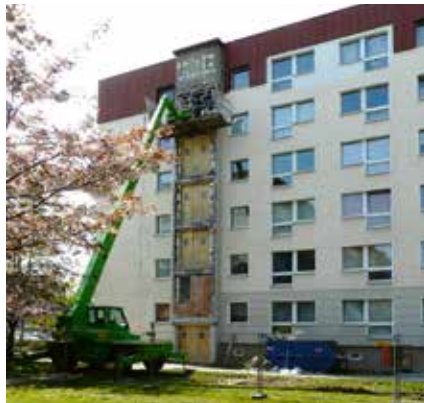
Wie hier am Ulberndorfer Weg wurden vielerorts Aufzüge nachgerüstet.
